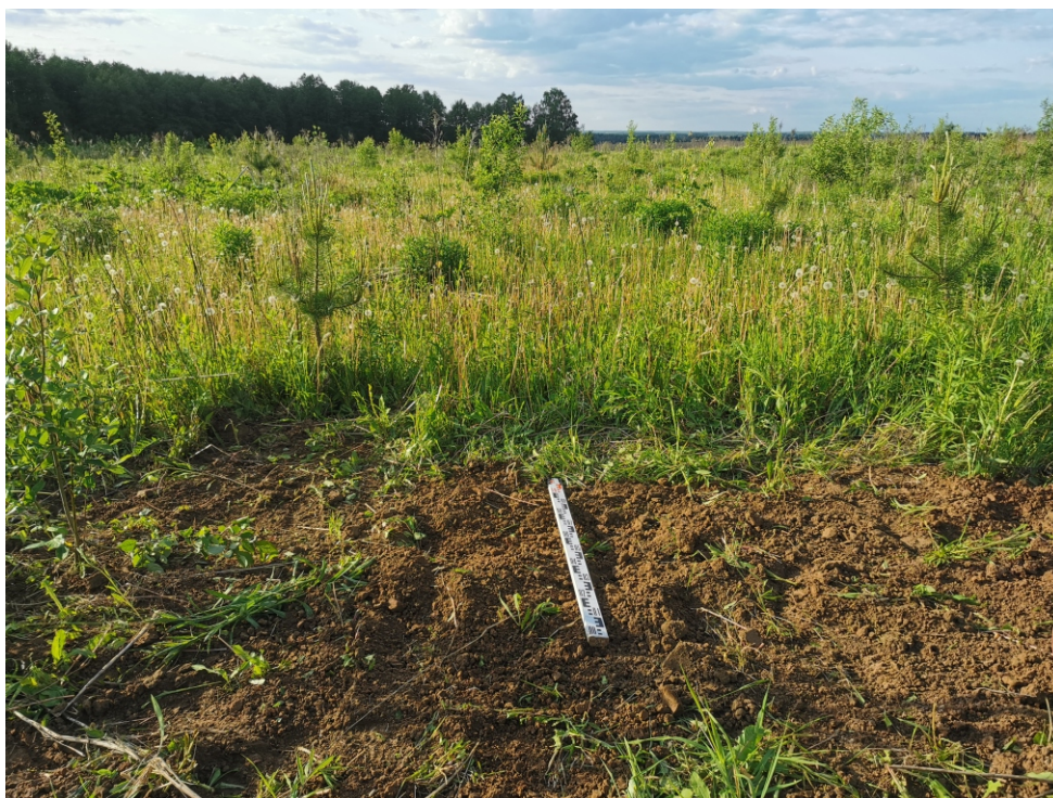
Рис. 33. Объект: «Отвод "Калужский". Средства ЭХЗ ЛЧ DN 250 с организацией электроснабжения. Реконструкция». Участок СКЗ №14, Калужская область, Ферзиковский район, д. Перцево, Рязанское РНУ. Ждамирово, поселение 4. Вид с Ю на рекультивацию шурфа 50.
