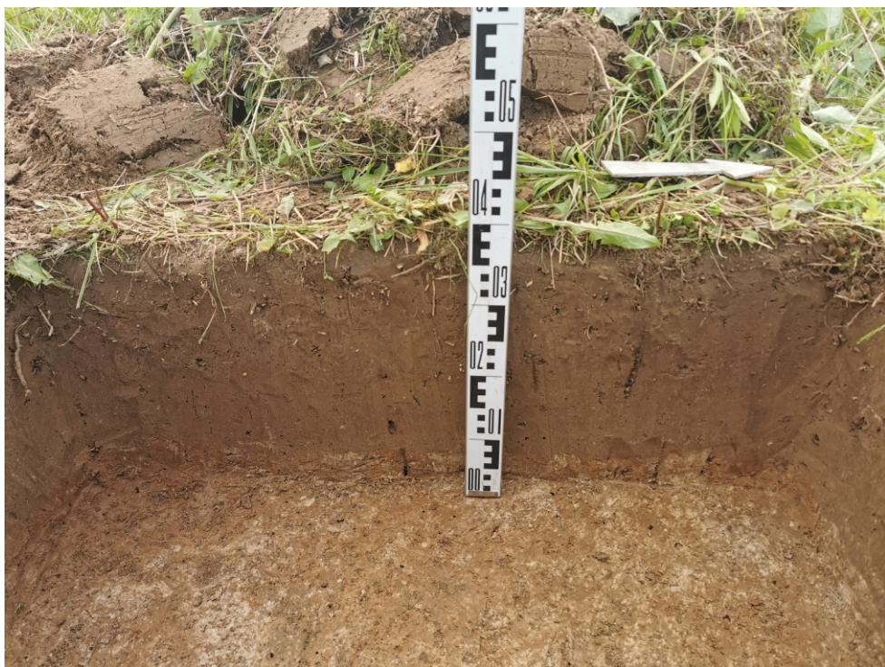
Рис. 16. Объект: «Отвод "Калужский". Средства ЭХЗ ЛЧ DN 250 с организацией электроснабжения. Реконструкция». Участок СКЗ №14, Калужская область, Ферзиковский район, д. Перцево, Рязанское РНУ. Ждамирово, поселение 4. Вид с В на западную стенку шурфа 49.
