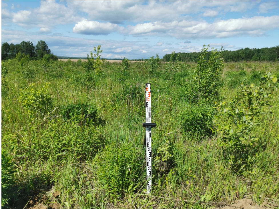
Рис. 63. Объект: «Отвод "Калужский". Средства ЭХЗ ЛЧ DN 250 с организацией электроснабжения. Реконструкция». Участок СКЗ №14, Калужская область, Ферзиковский район, д. Перцево, Рязанское РНУ. Ждамирово, поселение 4. Вид с Ю на разбивку шурфа 58.
