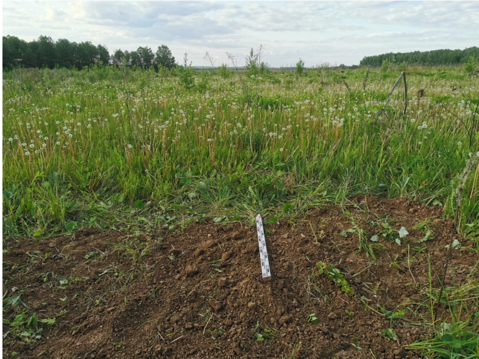
Рис. 20. Объект: «Отвод "Калужский". Средства ЭХЗ ЛЧ DN 250 с организацией электроснабжения. Реконструкция». Участок СКЗ №14, Калужская область, Ферзиковский район, д. Перцево, Рязанское РНУ. Ждамирово, поселение 4. Вид с Ю на рекультивацию шурфа 49.
