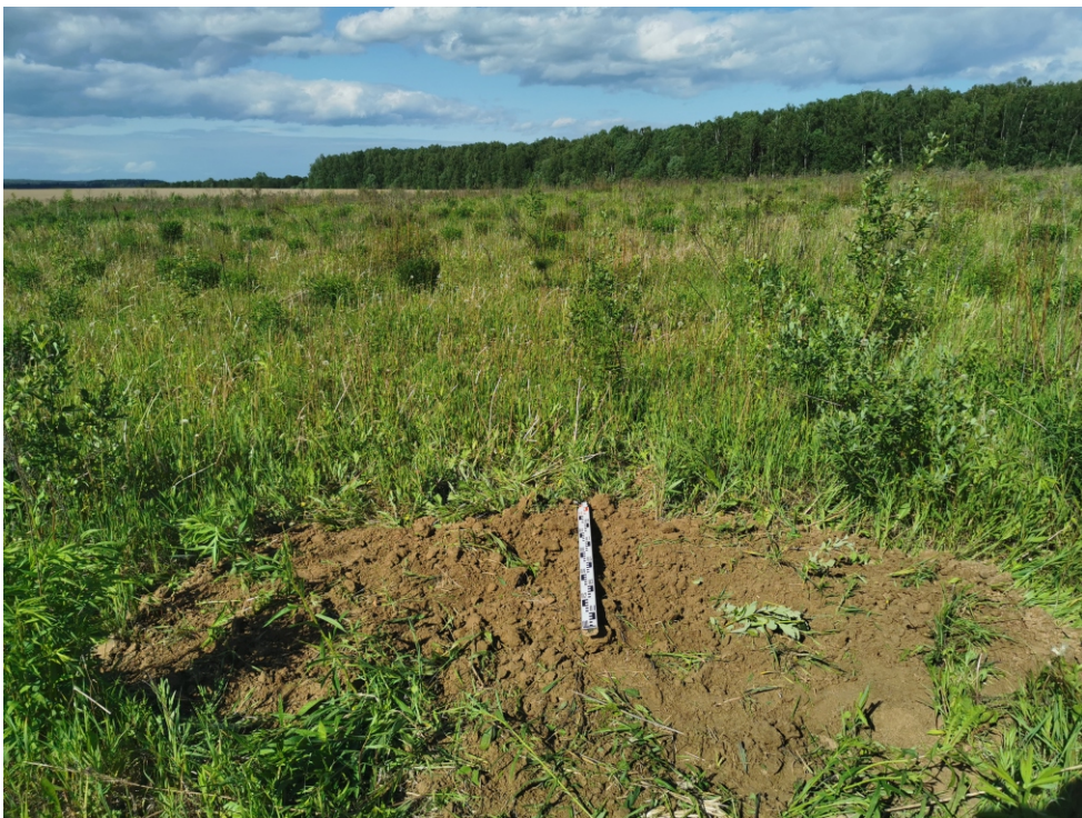
Рис. 78. Объект: «Отвод "Калужский". Средства ЭХЗ ЛЧ DN 250 с организацией электроснабжения. Реконструкция». Участок СКЗ №14, Калужская область, Ферзиковский район, д. Перцево, Рязанское РНУ. Ждамирово, поселение 4. Вид с Ю на рекультивацию шурфа 59.
