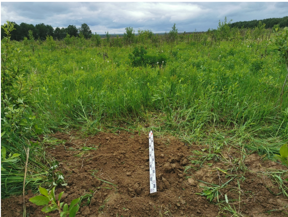
Рис. 54. Объект: «Отвод "Калужский". Средства ЭХЗ ЛЧ DN 250 с организацией электроснабжения. Реконструкция». Участок СКЗ №14, Калужская область, Ферзиковский район, д. Перцево, Рязанское РНУ. Ждамирово, поселение 4. Вид с Ю на рекультивацию шурфа 55.
