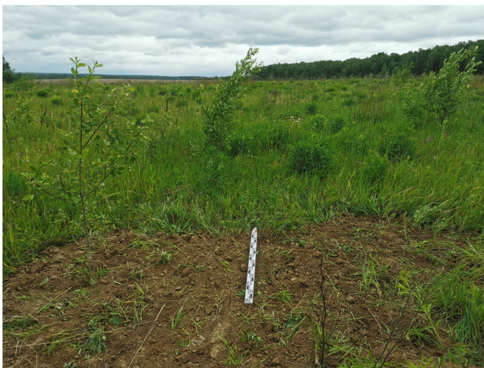
Рис. 46. Объект: «Отвод "Калужский". Средства ЭХЗ ЛЧ DN 250 с организацией электроснабжения. Реконструкция». Участок СКЗ №14, Калужская область, Ферзиковский район, д. Перцево, Рязанское РНУ. Ждамирово, поселение 4. Вид с Ю на рекультивацию шурфа 53.
