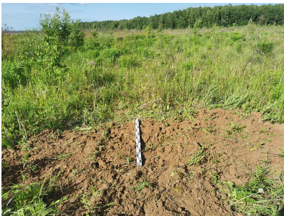
Рис. 82. Объект: «Отвод "Калужский". Средства ЭХЗ ЛЧ DN 250 с организацией электроснабжения. Реконструкция». Участок СКЗ №14, Калужская область, Ферзиковский район, д. Перцево, Рязанское РНУ. Ждамирово, поселение 4. Вид с Ю на рекультивацию шурфа 60.
