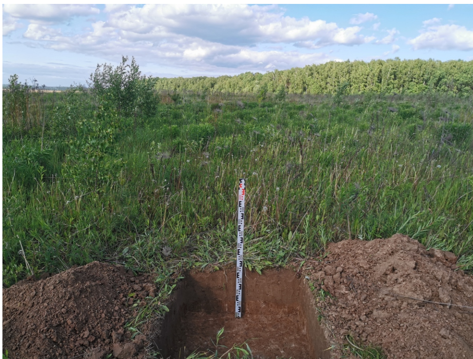
Рис. 81. Объект: «Отвод "Калужский". Средства ЭХЗ ЛЧ DN 250 с организацией электроснабжения. Реконструкция». Участок СКЗ №14, Калужская область, Ферзиковский район, д. Перцево, Рязанское РНУ. Ждамирово, поселение 4. Общий вид с Ю на шурф 60.
