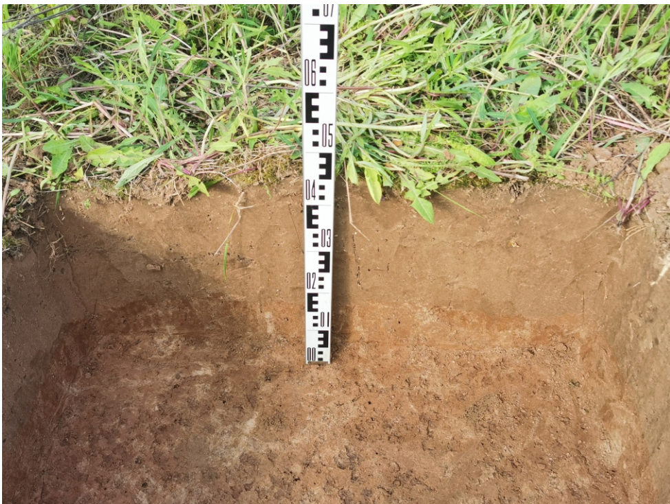
Рис. 80. Объект: «Отвод "Калужский". Средства ЭХЗ ЛЧ DN 250 с организацией электроснабжения. Реконструкция». Участок Участок СКЗ №14, Калужская область, Ферзиковский район, д. Перцево, Рязанское РНУ. Ждамирово, поселение 4. Вид с Ю на стенку шурфа 60.
