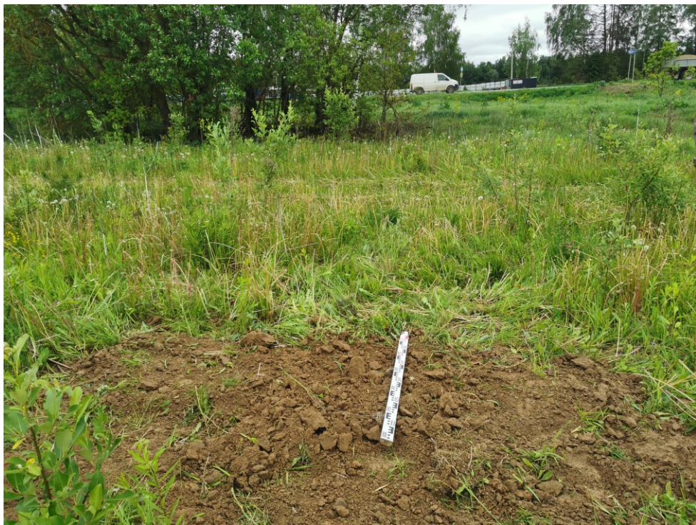
Рис. 42. Объект: «Отвод "Калужский". Средства ЭХЗ ЛЧ DN 250 с организацией электроснабжения. Реконструкция». Участок СКЗ №14, Калужская область, Ферзиковский район, д. Перцево, Рязанское РНУ. Ждамирово, поселение 4. Вид с С на рекультивацию шурфа 52.
