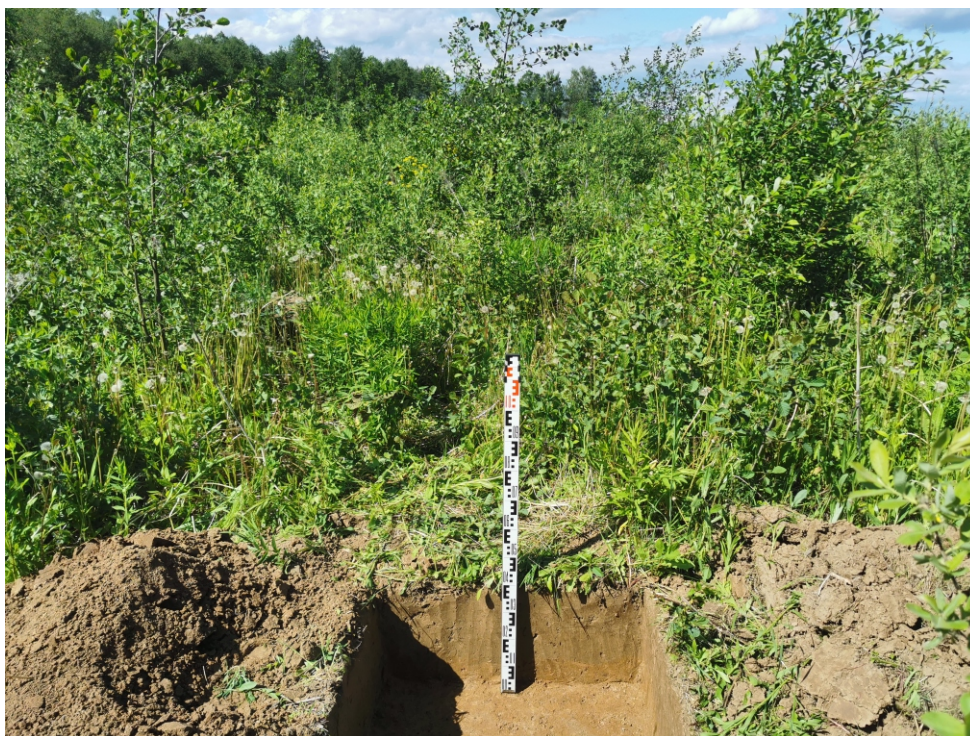
Рис. 61. Объект: «Отвод "Калужский". Средства ЭХЗ ЛЧ DN 250 с организацией электроснабжения. Реконструкция». Участок СКЗ №14, Калужская область, Ферзиковский район, д. Перцево, Рязанское РНУ. Ждамирово, поселение 4. Общий вид с Ю на шурф 57.
