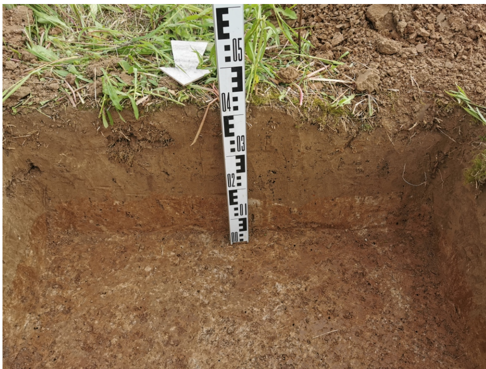
Рис. 28. Объект: «Отвод "Калужский". Средства ЭХЗ ЛЧ DN 250 с организацией электроснабжения. Реконструкция». Участок СКЗ №14, Калужская область, Ферзиковский район, д. Перцево, Рязанское РНУ. Ждамирово, поселение 4. Вид с С на южную стенку шурфа 50.
