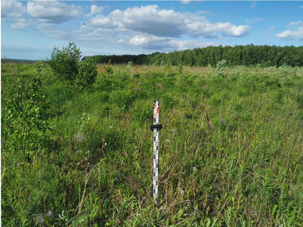
Рис. 79. Объект: «Отвод "Калужский". Средства ЭХЗ ЛЧ DN 250 с организацией электроснабжения. Реконструкция». Участок СКЗ №14, Калужская область, Ферзиковский район, д. Перцево, Рязанское РНУ. Ждамирово, поселение 4. Вид с Ю на разбивку шурфа 60.
