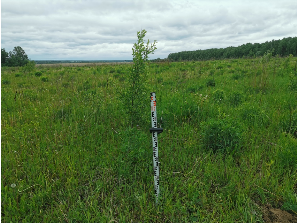
Рис. 43. Объект: «Отвод "Калужский". Средства ЭХЗ ЛЧ DN 250 с организацией электроснабжения. Реконструкция». Участок СКЗ №14, Калужская область, Ферзиковский район, д. Перцево, Рязанское РНУ. Ждамирово, поселение 4. Вид с Ю на разбивку шурфа 53.
