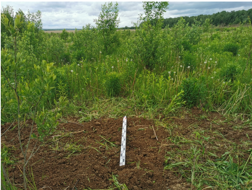
Рис. 58. Объект: «Отвод "Калужский". Средства ЭХЗ ЛЧ DN 250 с организацией электроснабжения. Реконструкция». Участок СКЗ №14, Калужская область, Ферзиковский район, д. Перцево, Рязанское РНУ. Ждамирово, поселение 4. Вид с Ю на рекультивацию шурфа 56.
